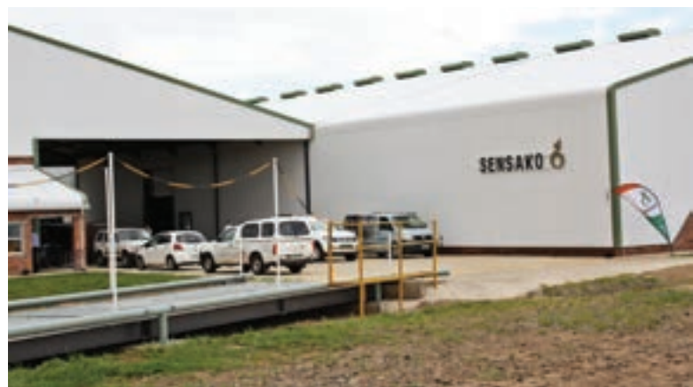
▲ Die aanleg net buite Bethlehem is saam met 'n nuwe gesamentlike onderneming tussen VKB en Sensako op 16 Januarie bekendgestel.
